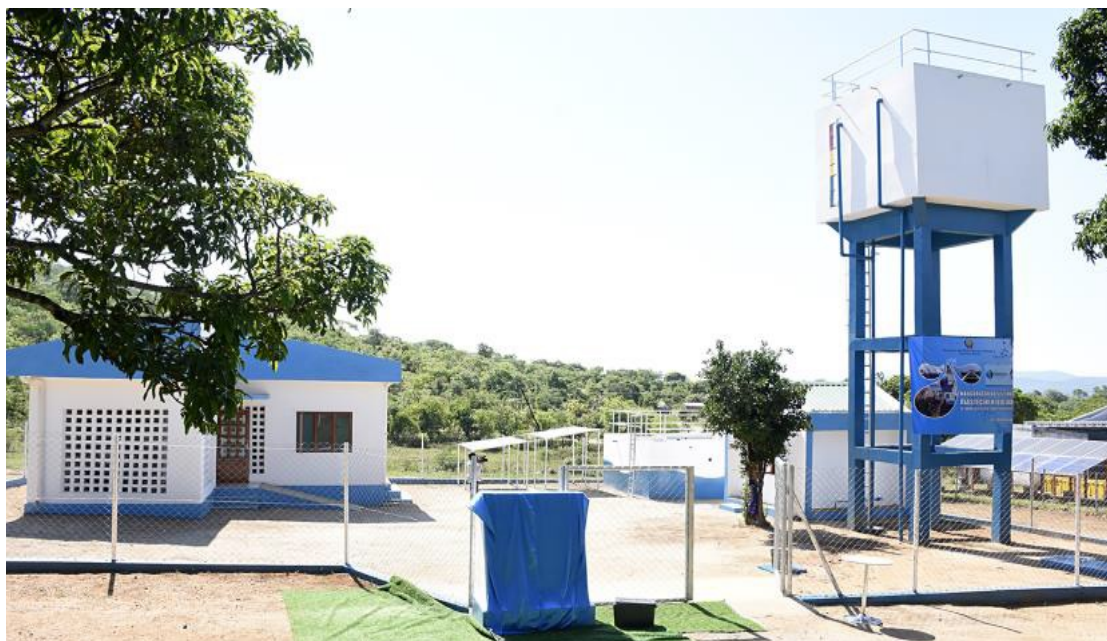
Sistema de Abastecimento de água Zambue-Zumbo, Prov. de Tete
