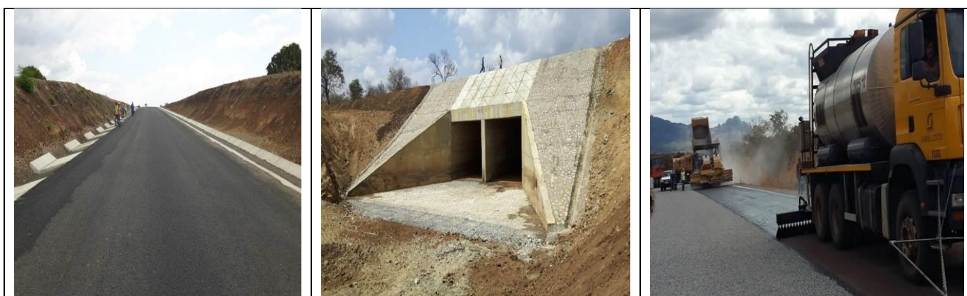
Asfaltagem da Estrada Nacional N13: Nampula-Cuamba (lote C Malema - Cuamba)
