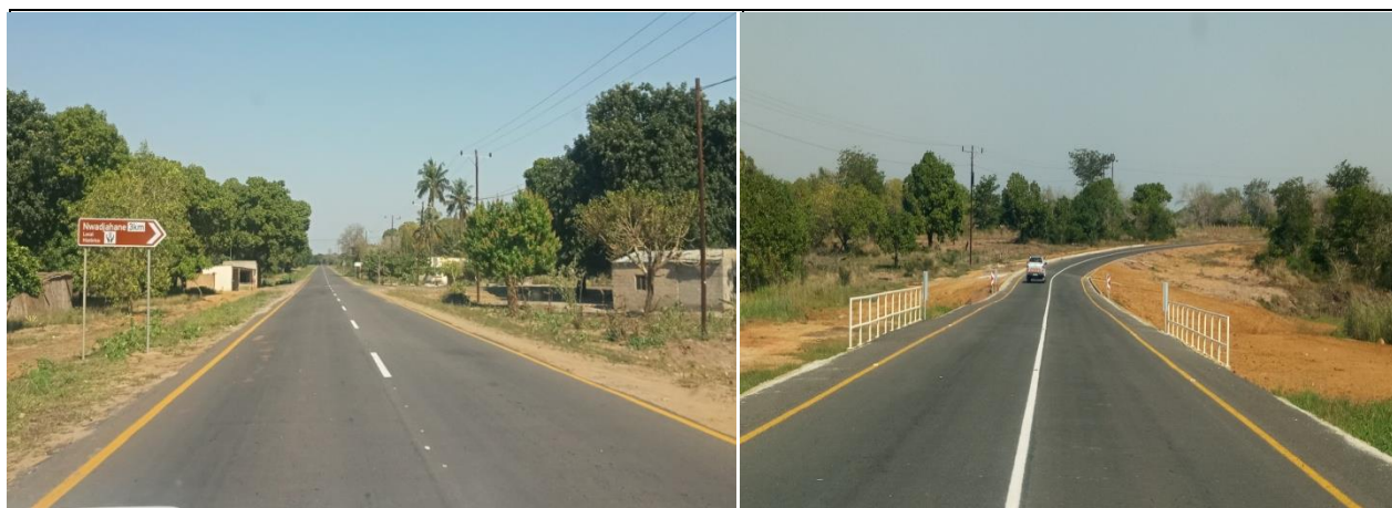
Asfaltagem da Estrada Nacional R443: Mandlakazi/Macuacua/Mawaela
