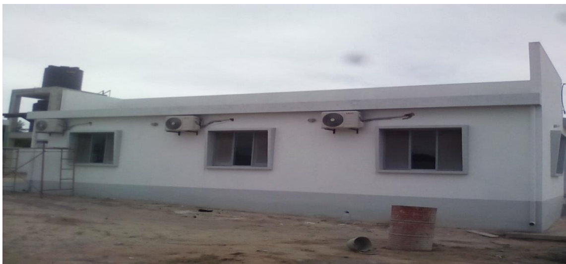
Obra de construção do Comando Distrital de Chemba, inaugurado em 2018.
