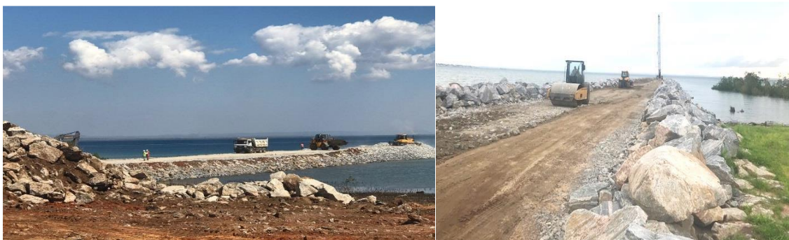
Obras da Base Logística de Pemba
