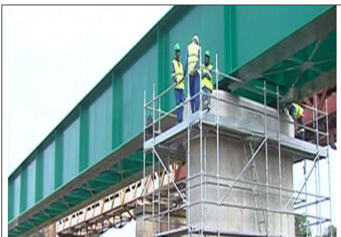
Ponte ferroviária sobre rio Umbeluzi em Boane
