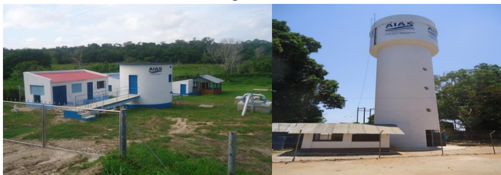
Sistema de Abastecimento de Água da Vila Sede de Mocímboa da Praia
